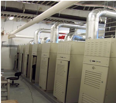
Compresor de gas y microturbina
